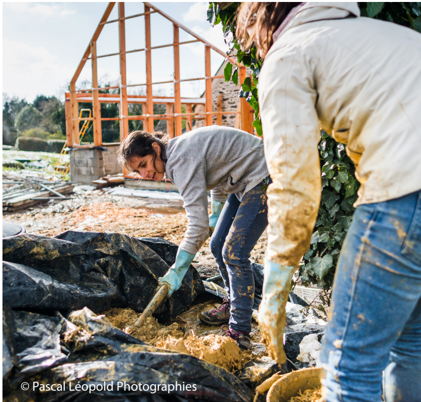
Pour la première fois à l'agence, le projet a fait l'objet d'un chantier participatif sur les 15 jours de mise en place des bottes de paille et les enduits terre. L'équipe a également activement participé au chantier avant ou après leur formation PRO-PAILLE. (l'agence est certifiée depuis 2020)
