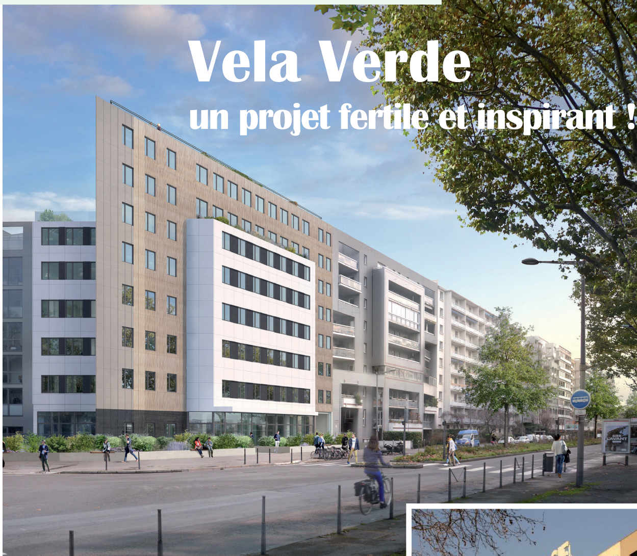
Vela Verde après réhabilitation
