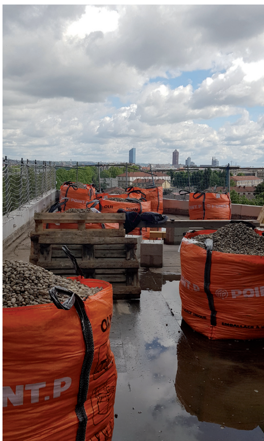
Chantier : réutilisation des gravillons de la terrasse.
