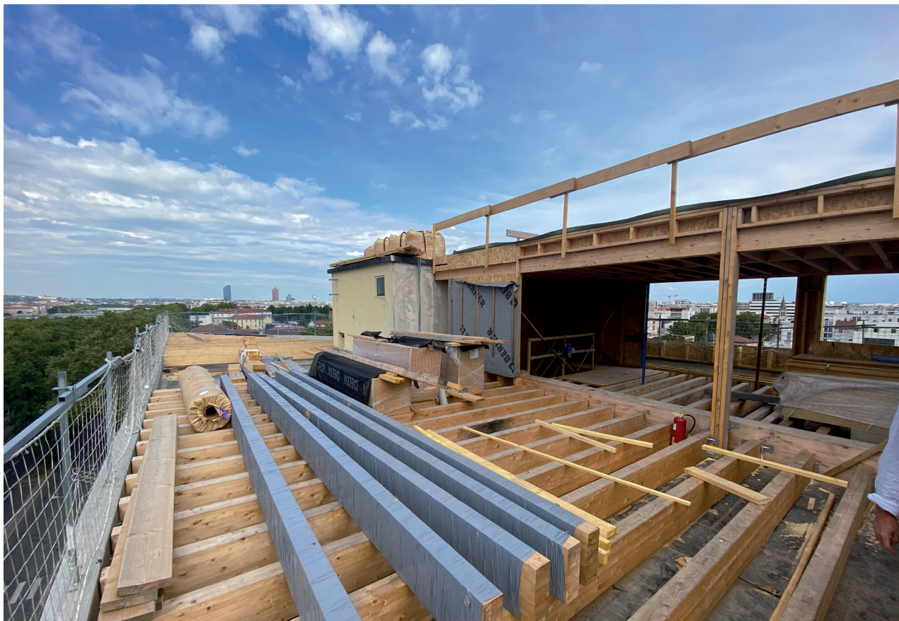
Chantier : plancher de la toiture terrasse et surélévation.
