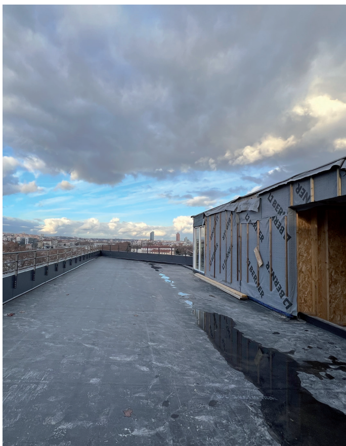
Chantier : revêtement d'étanchéité terrasse et surélévation.
