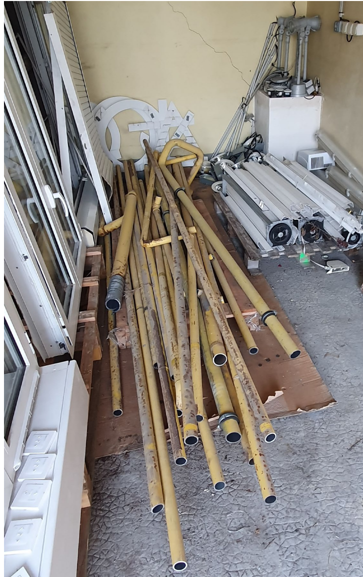
BARRES DEPOSEES SUR SITE
