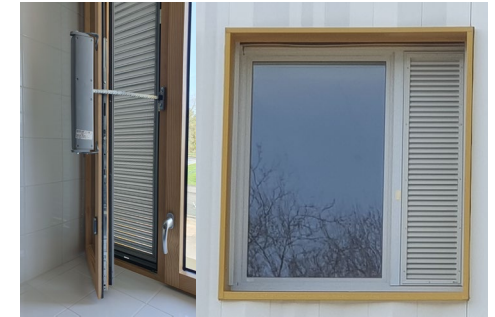
Ouvrants + grille pare-pluie + anti-intrusion + moustiquaire
