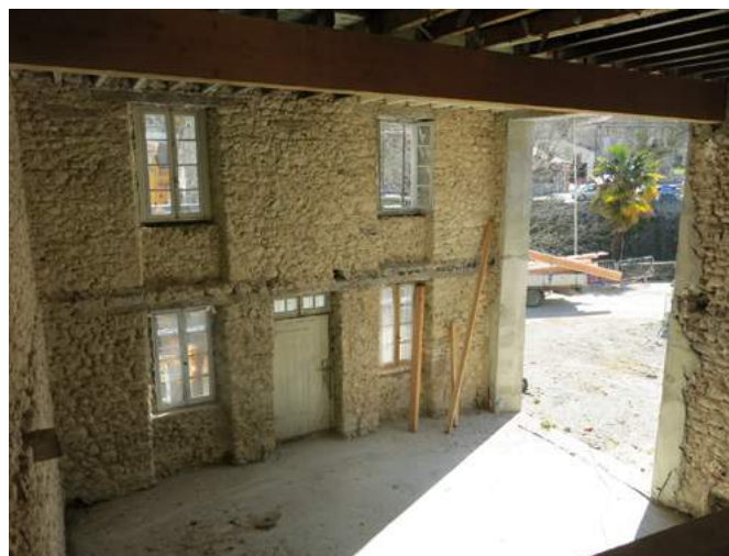
Maçonnerie de pierre, vue de l'intérieur, une fois l'enduit retiré
