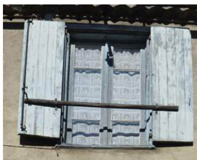
Une fenêtre d'origine en bois
