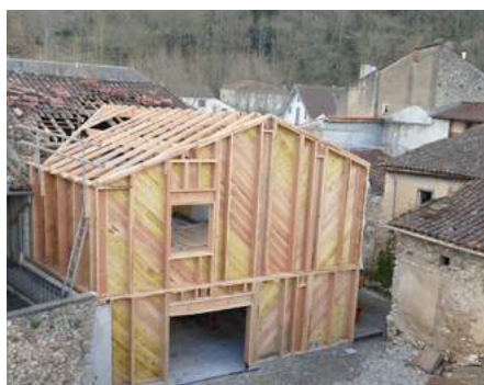
Construction de l'extension en ossature bois à la place de l'ancienne grange
