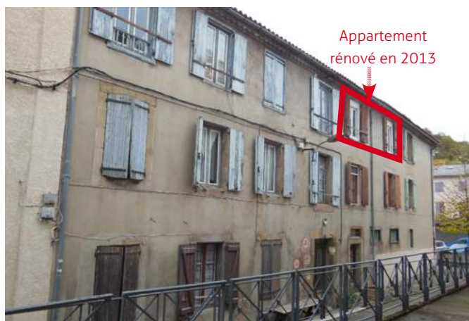
Vue du bâtiment avant les travaux
