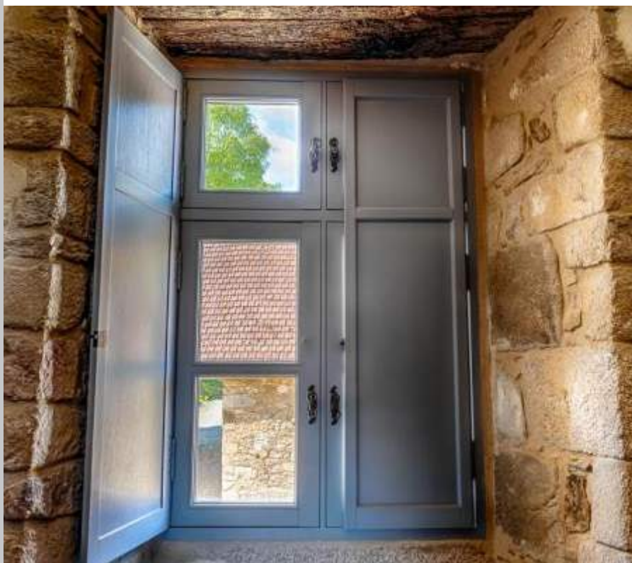
Menuiserie neuve réalisée à l'identique de la fenêtre d'origine, en conservant les petits bois, l'imposte et les volets intérieurs.
