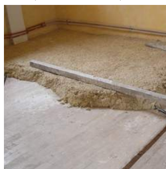
Réalisation de la dalle chaux-chanvre sur le plancher d'origine
