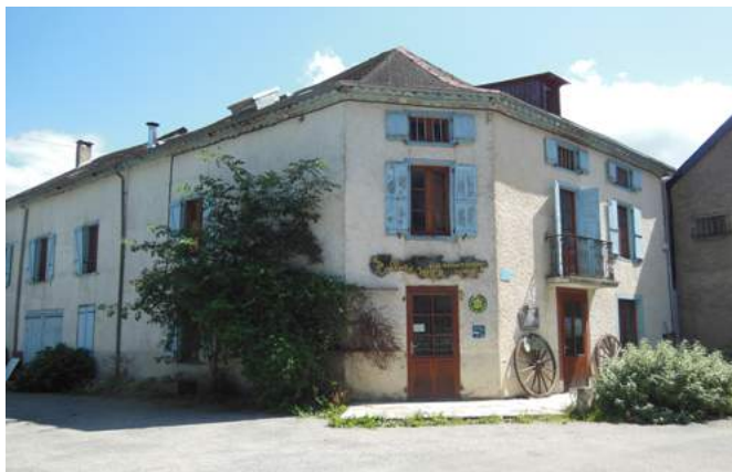
Façade donnant sur la rue
