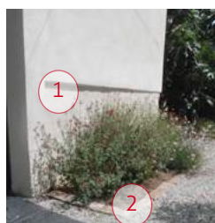
Traitement du pied de mur
