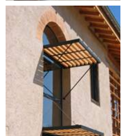
Brises soleil en façade sud
