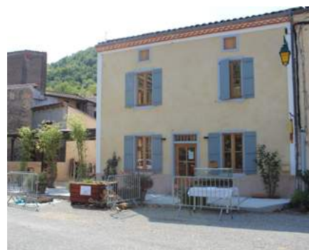
Façade Est : réfection des menuiseries à l'identique
