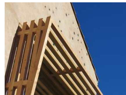
Détail façade Sud, incrustation de céramiques vernissées et brise-soleil
