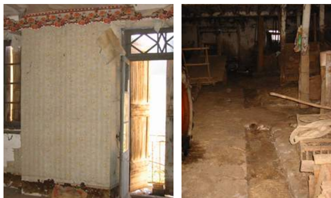
Entrée d'une des granges et vues intérieures des granges et de l'habitation
