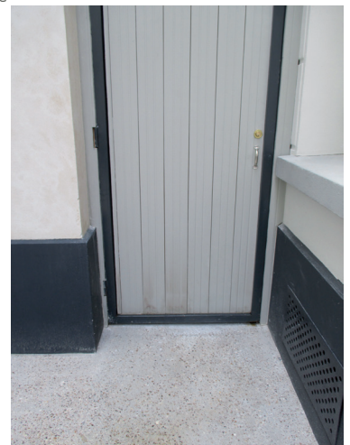
finition cour et pied de façade
