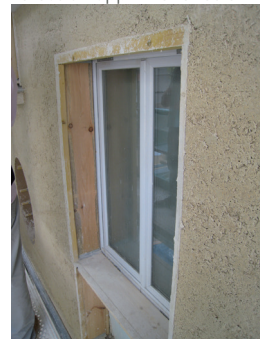
isolant béton de chanvre en façade et réfection tableau des baies
