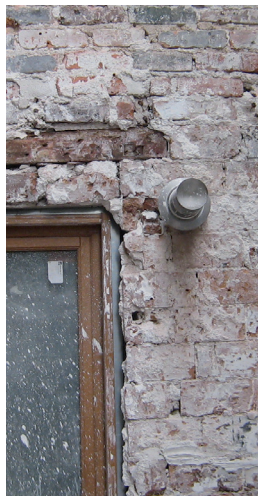
piochage enduit existant
