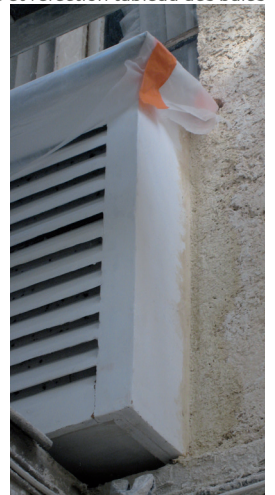
renovation des garde-mangers
