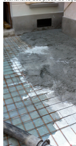
étanchéité de la cour par bétonnage
