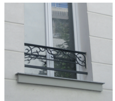
remplacement des garde-corps
