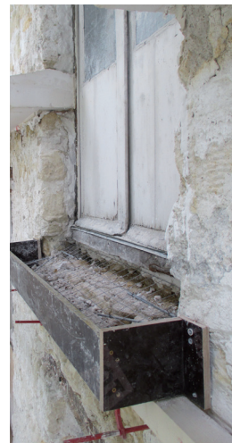
réfection appui de fenêtre
