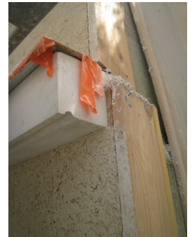
isolant béton de chanvre en façade et réfection tableau des baies
