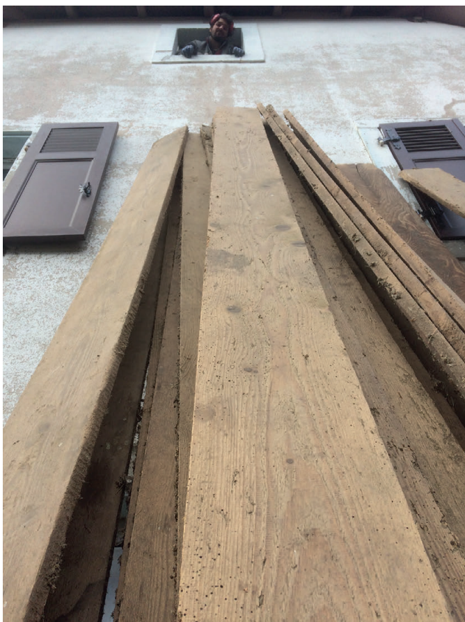
• Photo chantier - 2020 Planche bois de récupération provenant du démontage d'un plancher de la ferme attenante à rénover.
