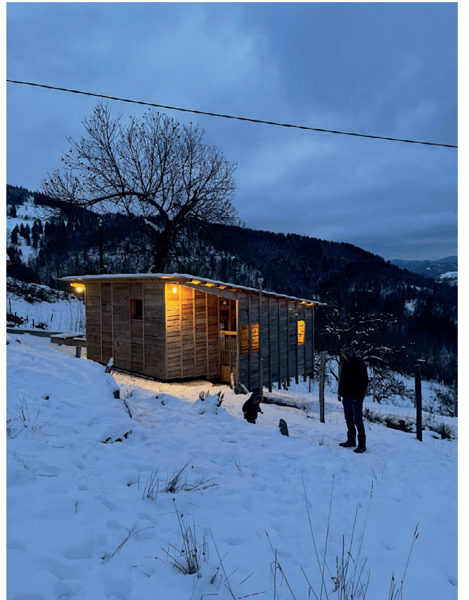
• Photo façade Nord-Ouest - hiver 2023
