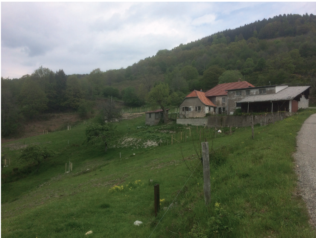
• Photo avant travaux - 2019
