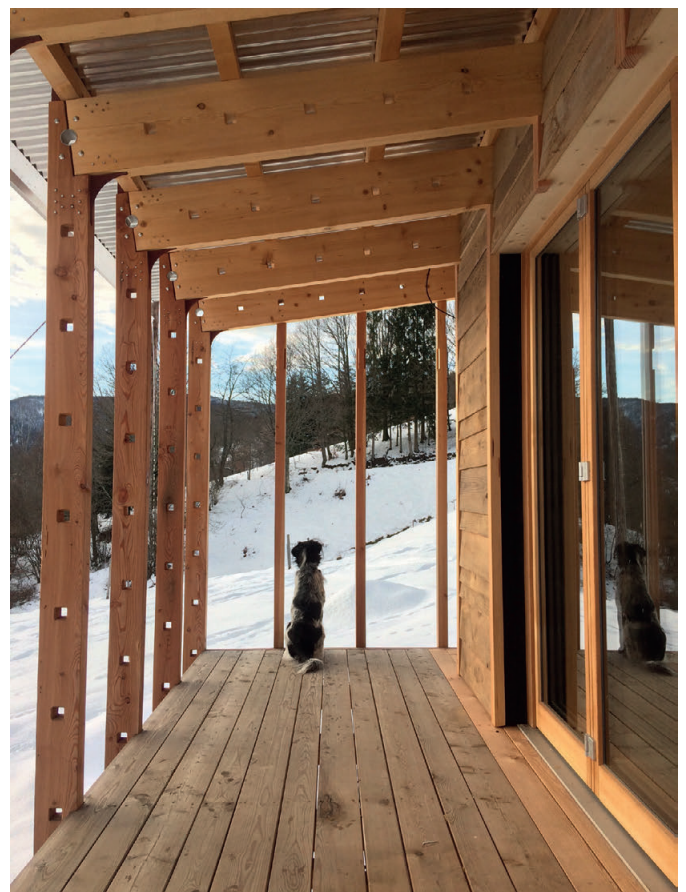
• Photo chantier - 2021 Afin d'éviter des fondations "La Lauwa" est suspendu à la toiture.
