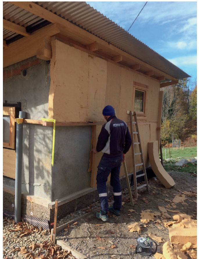
• Photo chantier - 2020 Isolation exterieur laine de bois
