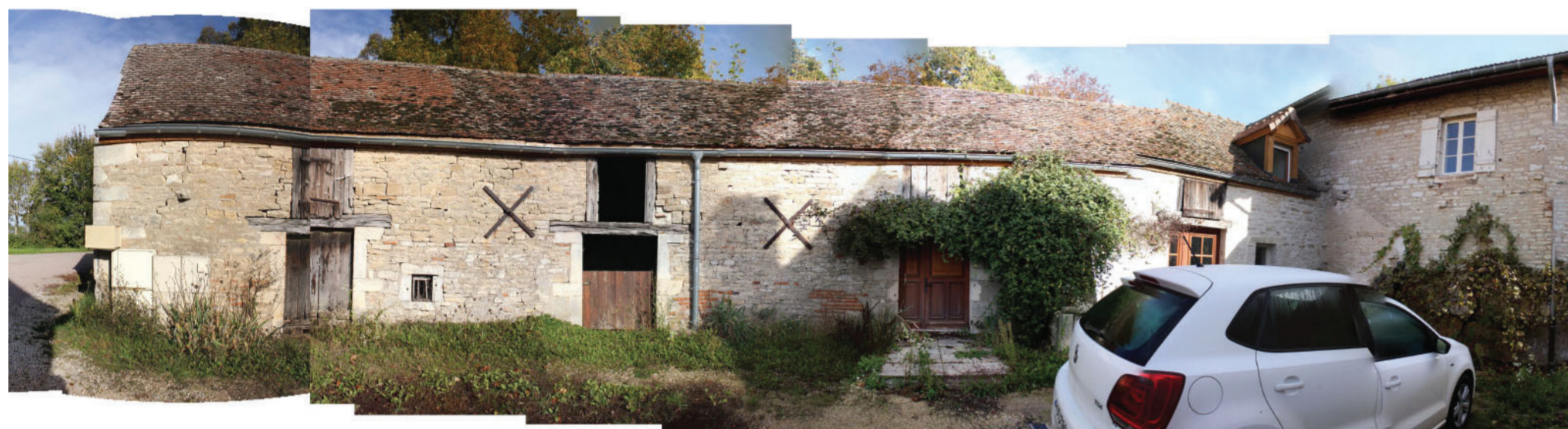
État des lieux façade sud
